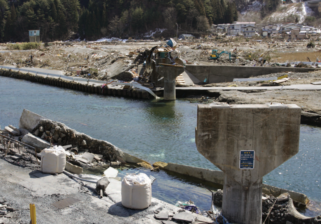
津波により破壊された織笠川に架かるＪＲ山田線の鉄橋
