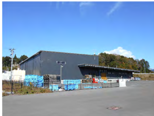
写真 織笠川左岸に立地した工場
