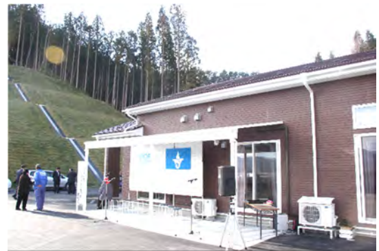
写真 大沢川向コミュニティセンター
