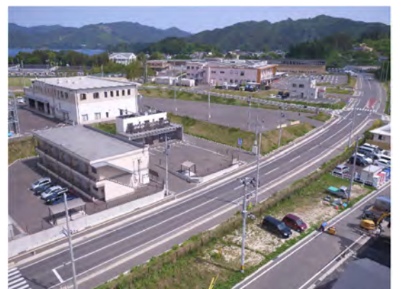
写真 公共防災拠点
