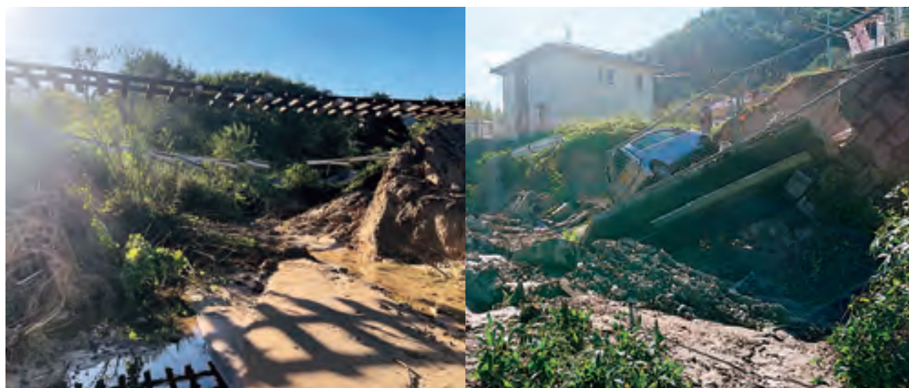
令和元年(2019)10月に襲来した「台風19号」は、その半年前に全線開通したばかりのリアス線に再び大きな傷を残し、路線は約半年間の運休を強いられた。しかし令和2年(2020)3月、リアス線は復旧工事を完了。鉄道の響きがもう一度、三陸に戻ってきた
