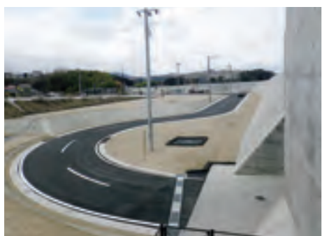
市澤さんが担当した、国道45号から織笠漁港へ向かう町道。上は工事前、下は工事後。道路整備に併せて宅地造成も行った場所で、宅地のなかには個人所有地も含まれていたそう。仮設の事務所で営業している方に、やっと本来の形で仕事をしてもらえるという嬉しさと、小規模ではあったが更地から完成形にできた達成感でいっぱいだったという
