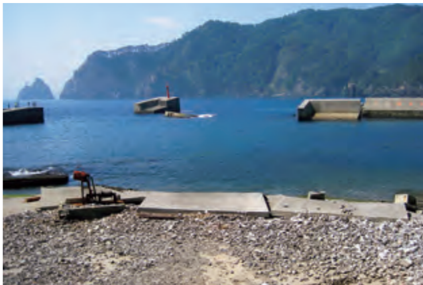
被災時の小谷島漁港の様子。津波に襲われた堤防が無残な姿になっている。左は完成間近の小谷島漁港。きれいな姿に生まれ変わった
