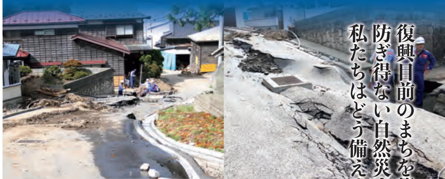
流れた水により裂けた路面。田の浜地区のほか、大浦地区、織笠地区、豊間根地区でも河川の越水、道路の冠水・崩落が相次いだ
