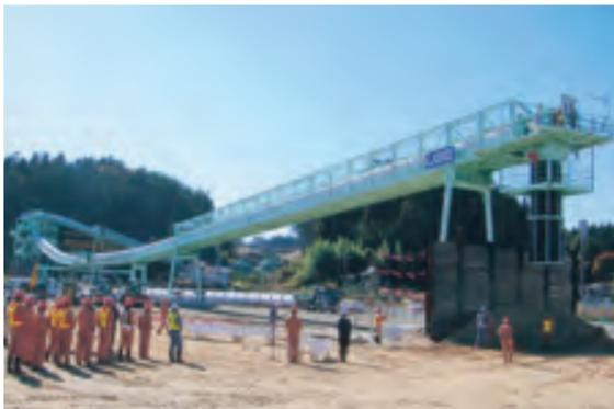
大型ベルトコンベヤーを設置して、効率よく土砂を搬出
