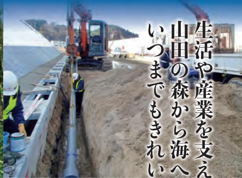
水道管の災害復旧工事
