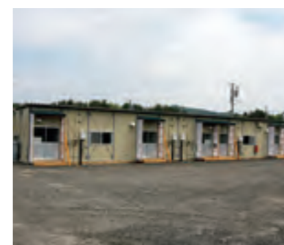
順次建設された仮設住宅・町民ランド(5月19日)
