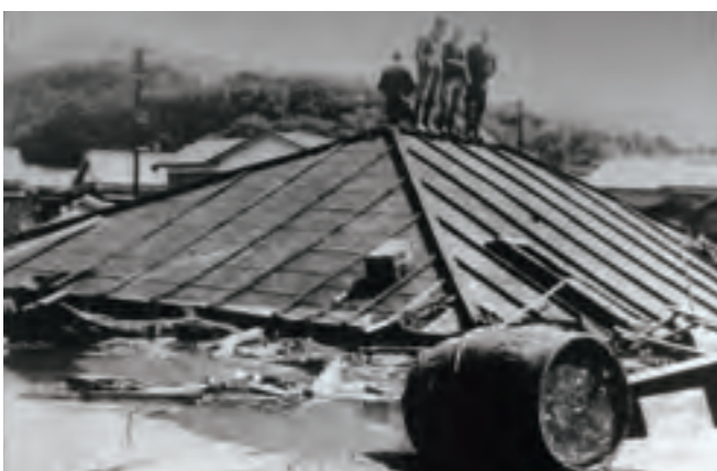
チリ地震津波での被害
