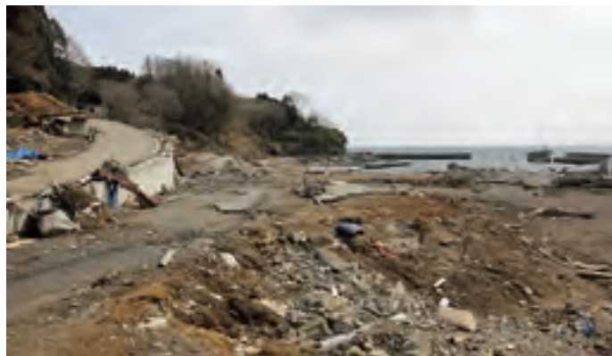
被災した小谷鳥地区
