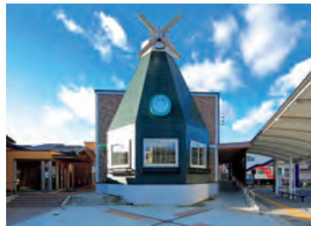
三陸鉄道陸中山田駅 外観 (撮影日：2020年8月)
