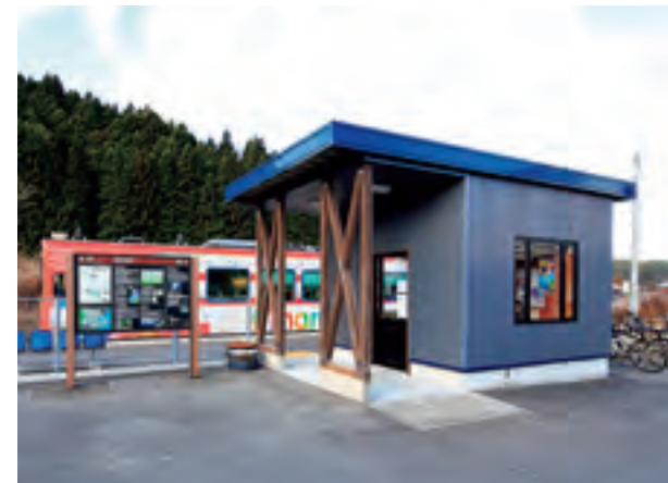
三陸鉄道豊間根駅 外観 (撮影日：2020年12月)
