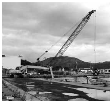
大沢漁港の復旧
