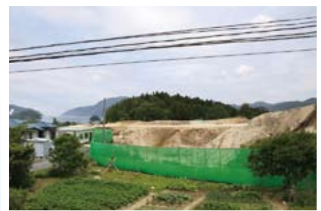
織笠高台団地の工事状況(6月24日撮影)
