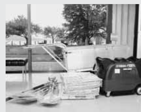
発電機などの資機材
