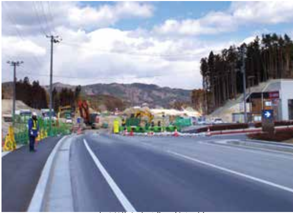
工事が進む細浦・柳沢線
