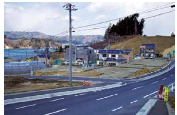
整備が完了した高台住宅団地（船越地区）
