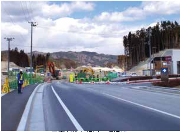
工事が進む細浦・柳沢線
