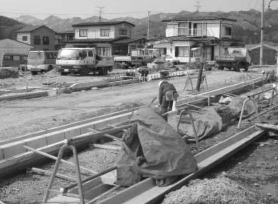
快適な生活基盤の充実を目指し、区画整理事業が進められる柳沢地区
