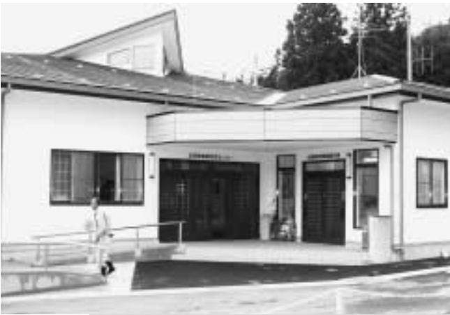
完成した防災センターと役場支所。建物全体がバリアフリー構造になっています
