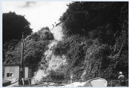
平成9年に起きた大雨によるがけ崩れ(船越地区)
