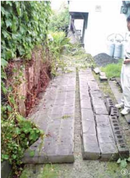
①四十八坂展望所では手すりの土台部分に5センチの段差とすき間ができて、手すり自体も数カ所破損しました②林道川目線では、道路に巨大な岩が崩れてきました③八幡町ではブロック塀が10センチにわたって倒れました
