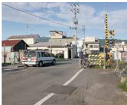
歩道設置工事が行われる町道中央長崎線
