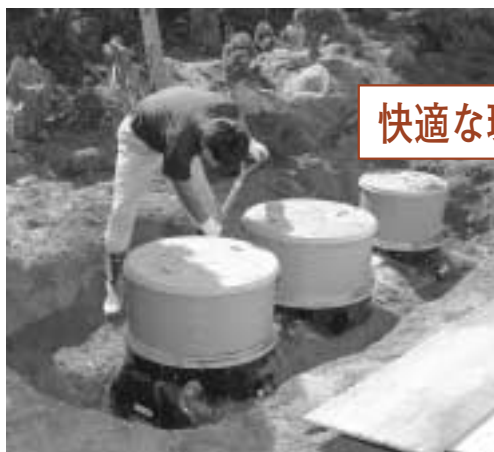
小型合併処理浄化槽(7人槽)の設置の様子
