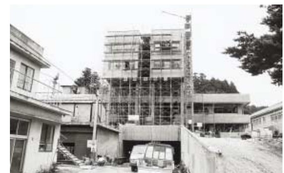
▲役場庁舎建築工事（昭和49年）
