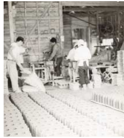
▲町営ブロックセンター (昭和36年ころ、豊間根) 住宅不足を解消するため 漁民アパート建設に使う ブロックを製造した
