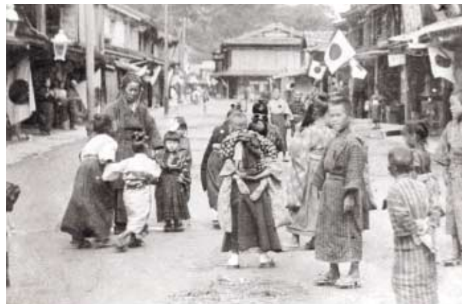
▲祝日の日（明治末期～大正初期）通り沿いの家々は2階建てで、軒に国旗が掲げられ、子供たちも晴れ着で着飾っている。現在の国道45号、中央町である
