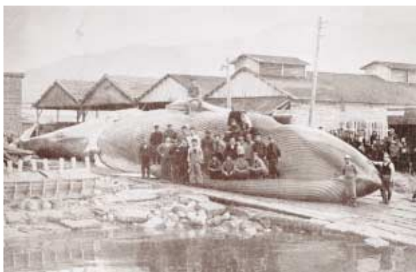
▲鯨の解体(昭和33年ころ)日東捕鯨株式会社に水揚げされたシロナガスクジラ。この後解体された
