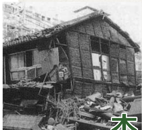
地震で倒壊した家屋
