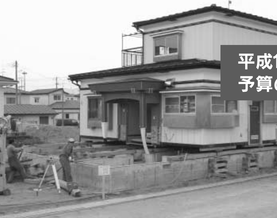
柳沢・北浜地区で進められている土地区画整理事業。 現在、道路築造工事や宅地造成工事などが行われています（写真は民家を移動するひき家作業の様子）
