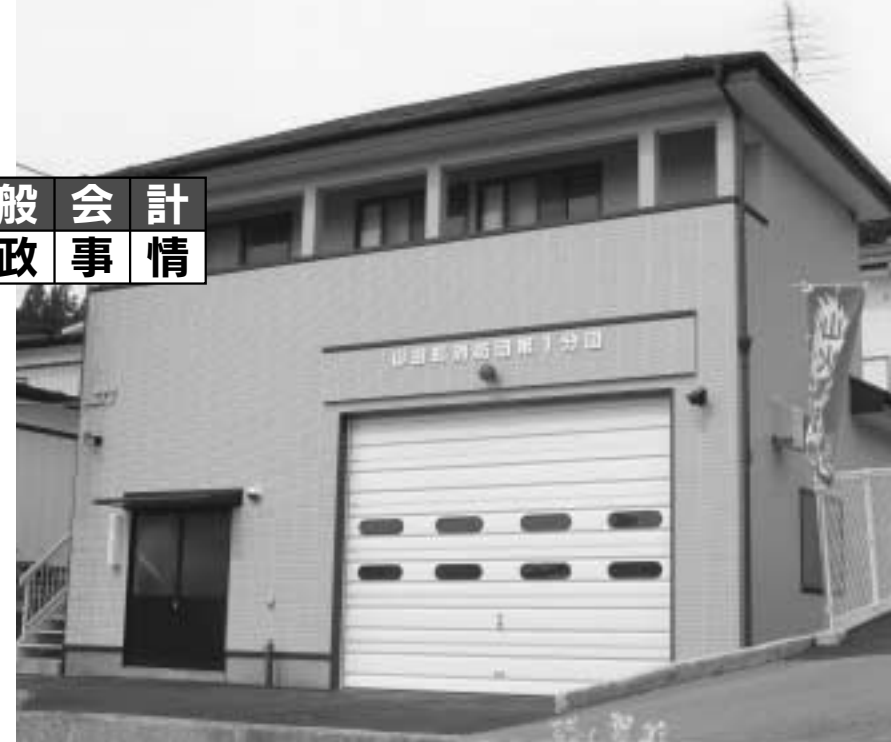
老朽化に伴い、今年3月に建て替えられた第1分団屯所
