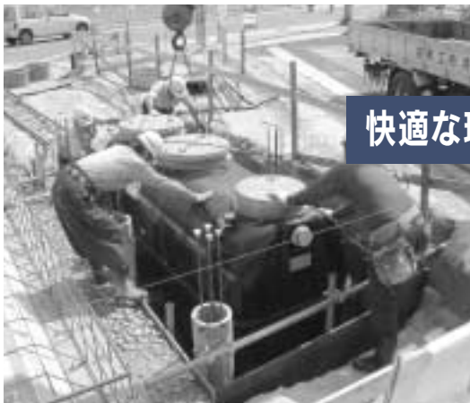
合併処理浄化槽(10人槽)の設置の様子
