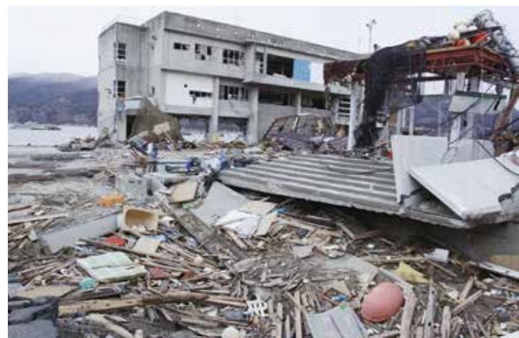
屋上近くまで浸水した3階建ての船越漁村センター(平成23年3月24日午後4時48分撮影)
