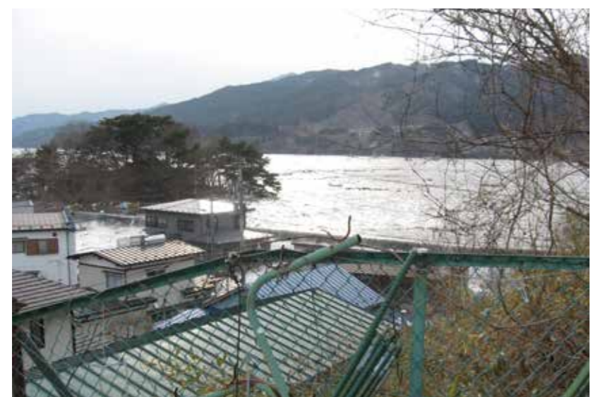
船越小のすぐ南側にある日向脇集落の防潮堤を越える津波（平成23年3月11日午後3時17分撮影）
