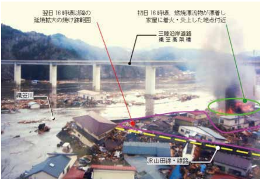
織笠地区で火の付いたがれきが漂着して発生したとみられる火災。 写真奥が織笠川上流
