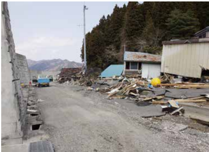
花崎さんの作業場に近い一帯の被災状況(平成23年3月25日撮影)。津波は高さ6.6メートルの防潮堤(左)をやすやすと越えた
