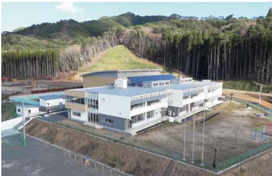
海拔24メートルの高さに再建された現在の船越小学校
