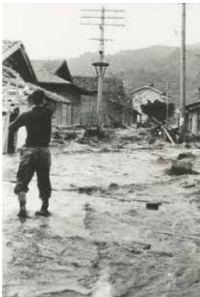
織笠の町中に侵入するチリ地震津波の濁流。かなりの流速があるように見える
