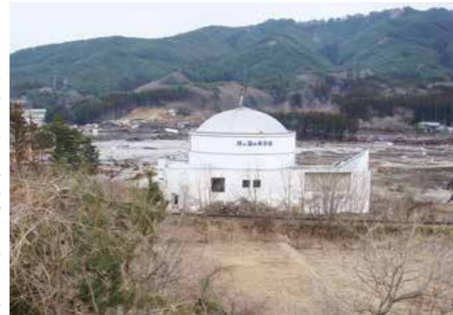
鯨館が立地する船越低地を遡上する津波(平成23年3月11日午後4時9分撮影)
