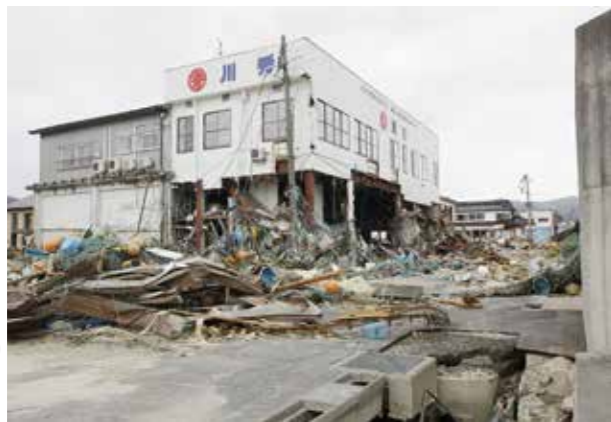
山田漁港に面する防潮堤から10メートル程度の距離にあり、津波の直撃を受けた水産加工会社（平成23年3月25日午後3時9分撮影）
