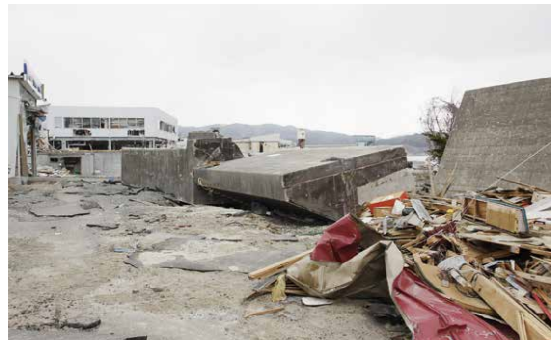
山田地区で倒壊した防潮堤と、波打つ形状となった路面アスファルト(平成23年3月25日午後2時58分撮影)
