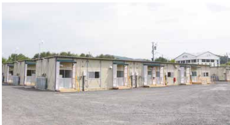
完成した町民グラウンドの仮設住宅団地（平成 23 年 5 月 19 日）
