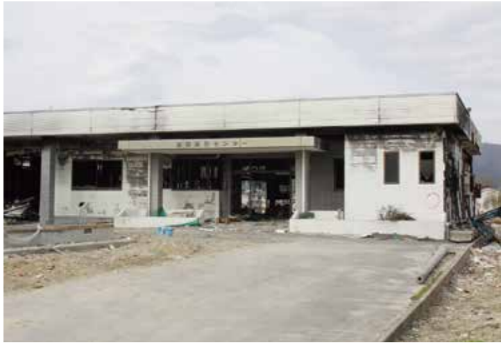
津波で浸水した後、火災が及んだ飯岡防災センター（平成23年5月7日）
