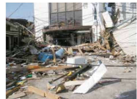
国道45号沿いの金融機関では、津波で1階のガラス戸などが突き破られた(平成23年3月14日午前9時40分撮影)
