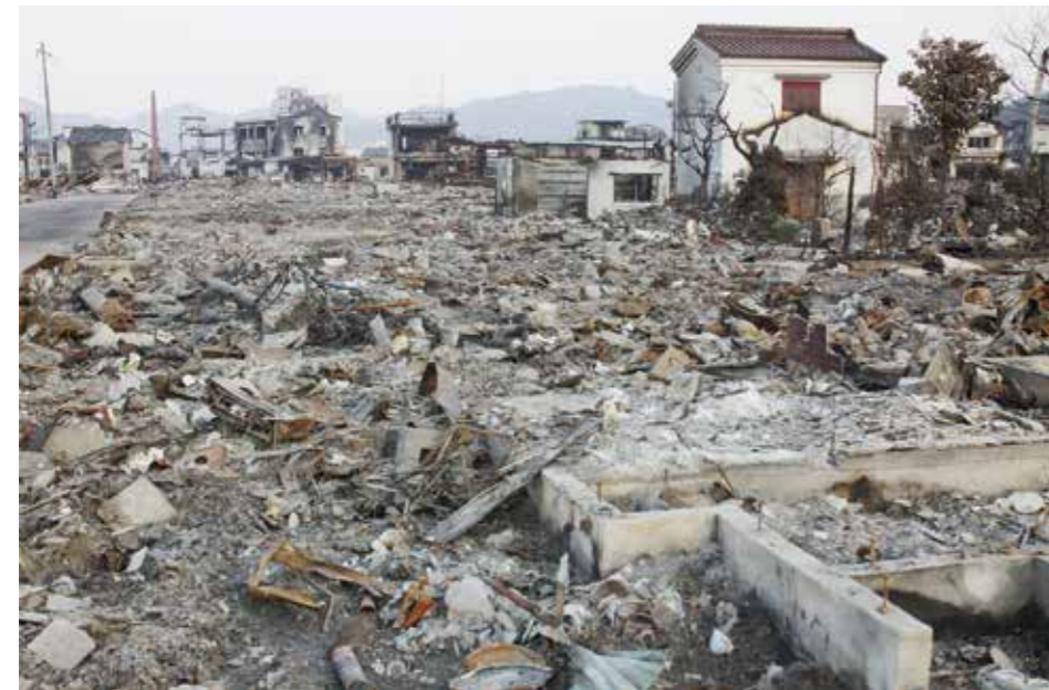
中心街の「全壊(流失)」地区で、津波とその後の火災に耐えた蔵(右上) =平成23年3月31日 午後4時45分撮影
