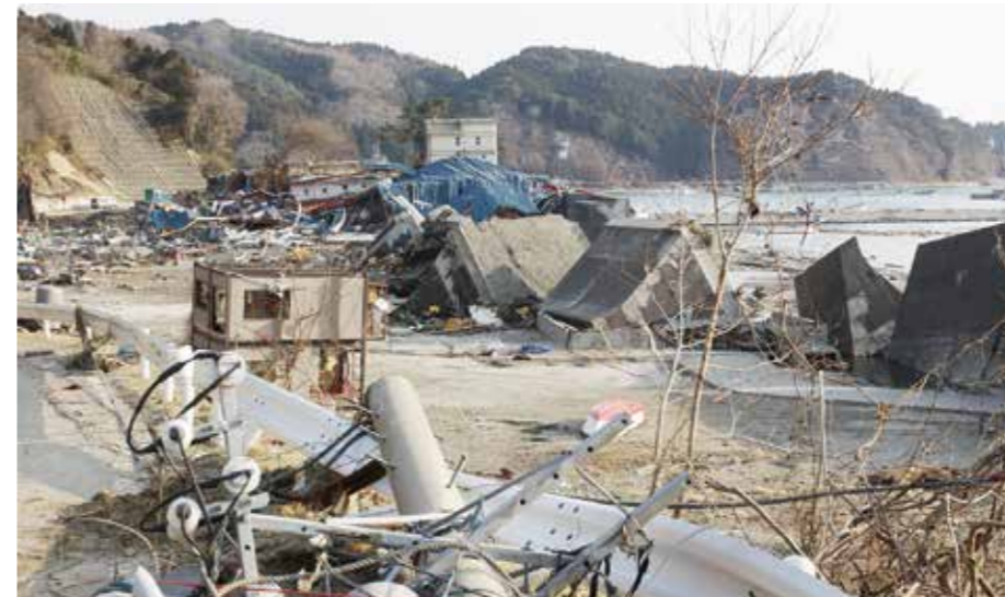
田の浜地区では、ほぼ全区間で防潮堤が破壊された(平成23年3月19日午後3時48分撮影)
