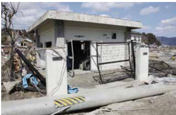
被災した織笠第二水源池 (平成23年3月19日午前11時40分撮影)。地下水をくみ上げるポンプが機能しなくなった
