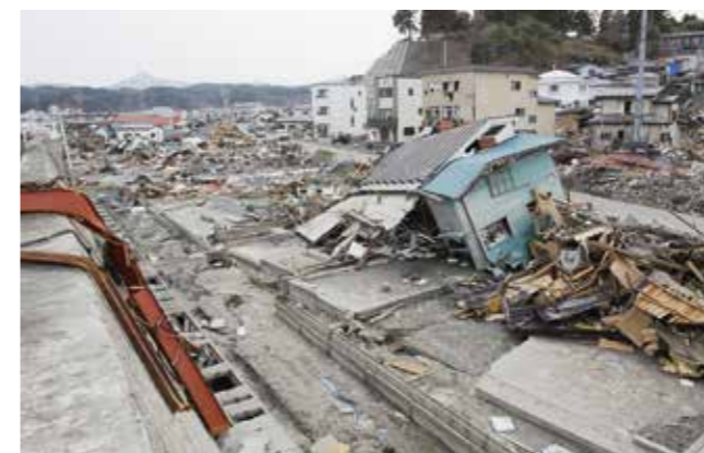
津波は防潮堤(左側)を越えて、北浜地区の家屋などを大きく破壊した(平成23年3月25日午後4時12分撮影)
