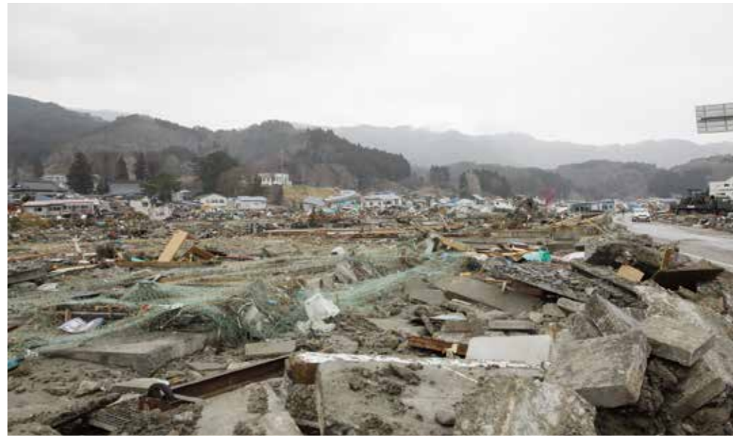
大沢地区上条付近の被災状況(平成23年3月21日午後4時44分撮影)。同地区の防潮堤は、東側と西側の両端が低く、そこから勢いよく津波が流れ込んだ
