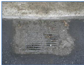
排水柵の土砂詰り清掃
