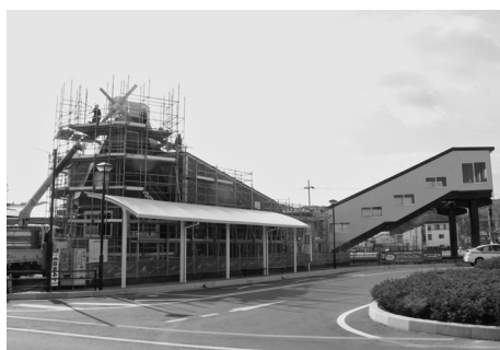
各駅をひと足先に見学しませんか （写真は建設中の陸中山田駅）
