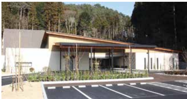
新斎場建設工事費
