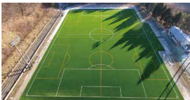
町民総合運動公園ラグビー・サッカー場人工芝新設工事費
