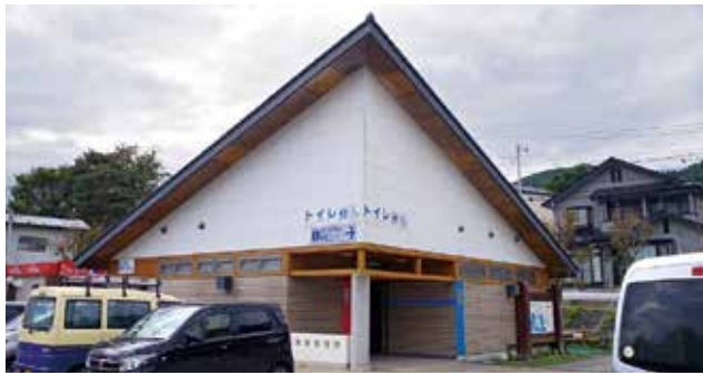
道の駅外部トイレ改修工事費
