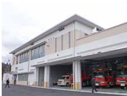
完成した山田消防署新庁舎
