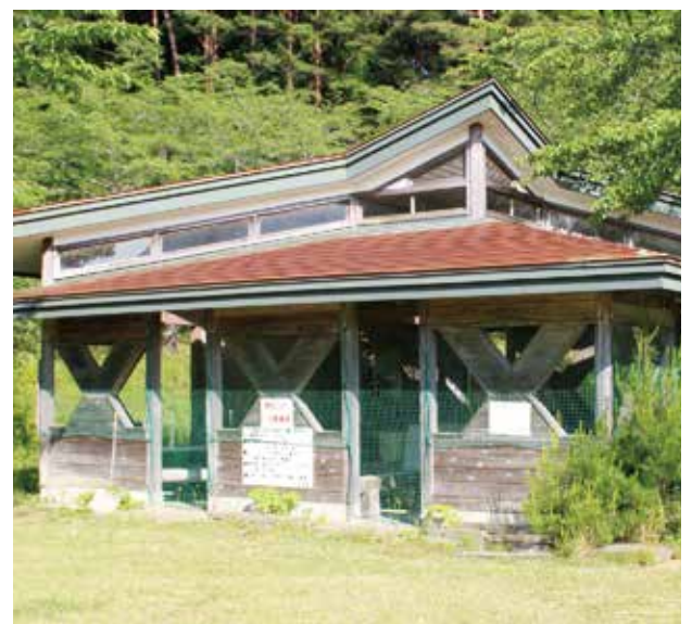
修繕後再開予定のバーベキューハウス
