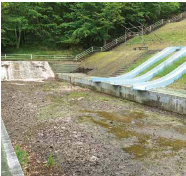
解体撤去予定のジャブジャブプール
