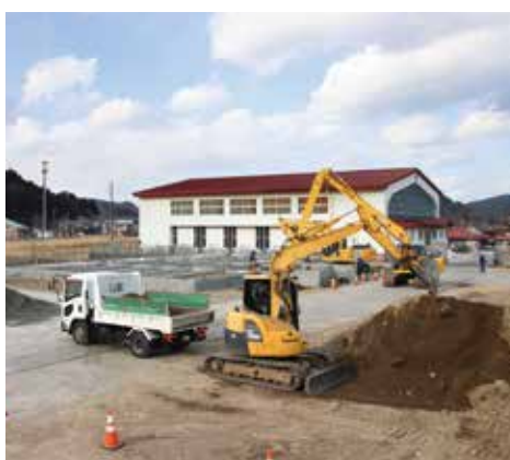
豊間根地区集会施設兼豊間根支所整備の様子
