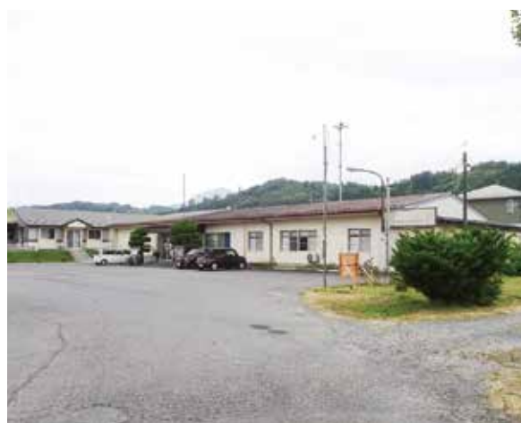
跡地有効活用施策で地域の賑やか創生を！ (豊間根支所)
