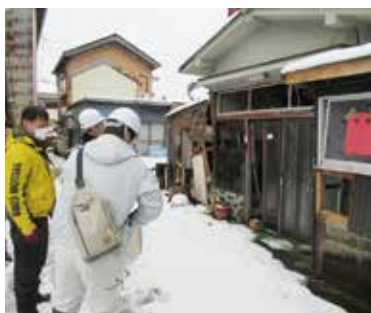
被災した家屋の調査を行う様子
