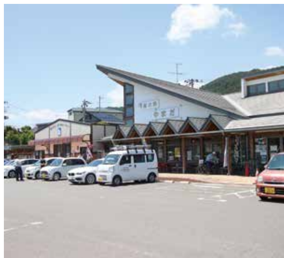
ふれあいパーク山田は今後リニューアル工事が予定されています
