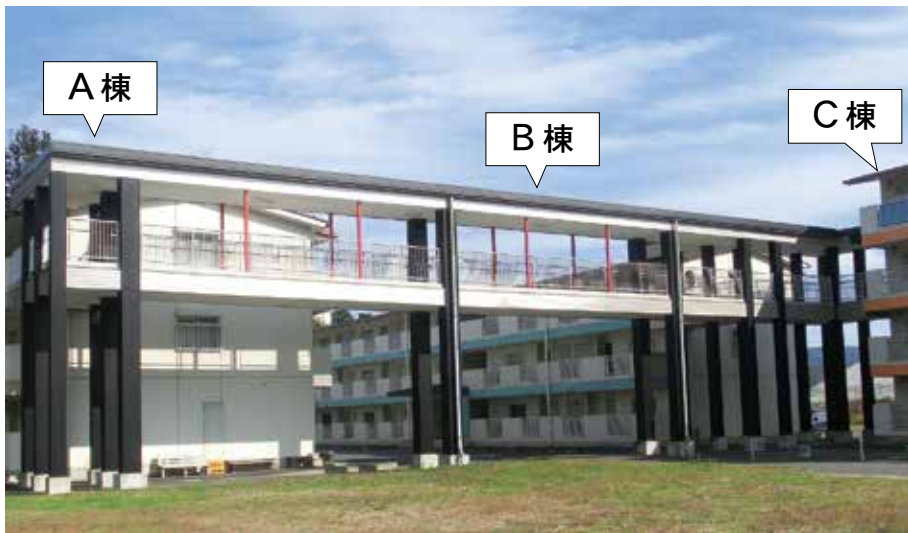
2階の住民の緊急搬送時に階段を使わないような対策を
