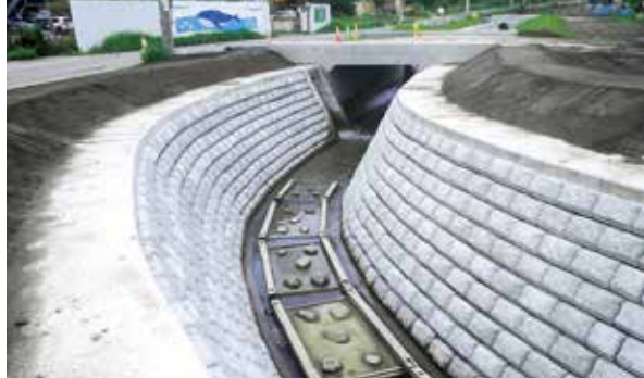
土砂災害や浸水被害を防ぐことを目的に施工された準用河川女川改修工事（田の浜地区）
