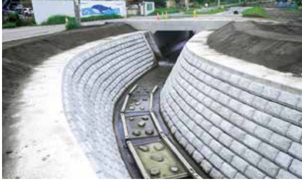
土砂災害や浸水被害を防ぐことを目的に施工された準用河川女川改修工事（田の浜地区）
