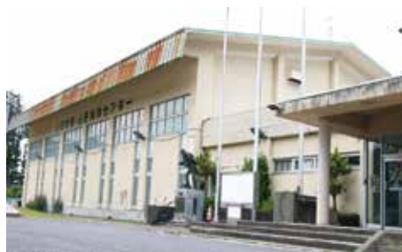
改修工事を行う町B&G海洋センター
