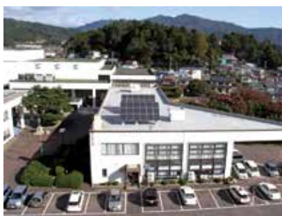
太陽光発電蓄電システム設置工事費 1億2185万円
