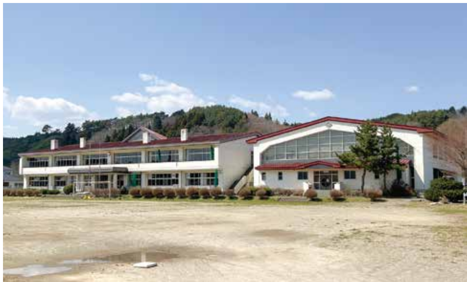
集会所建設予定地である旧豊間根中学校
