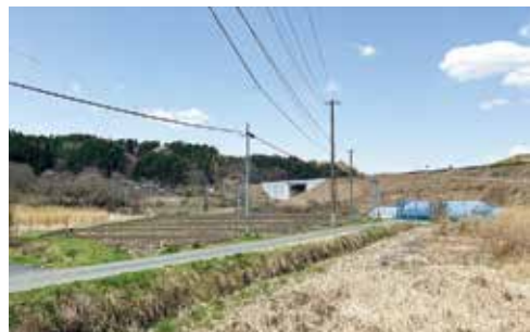
8年度の工事着手を目指す田名部地区圍場
