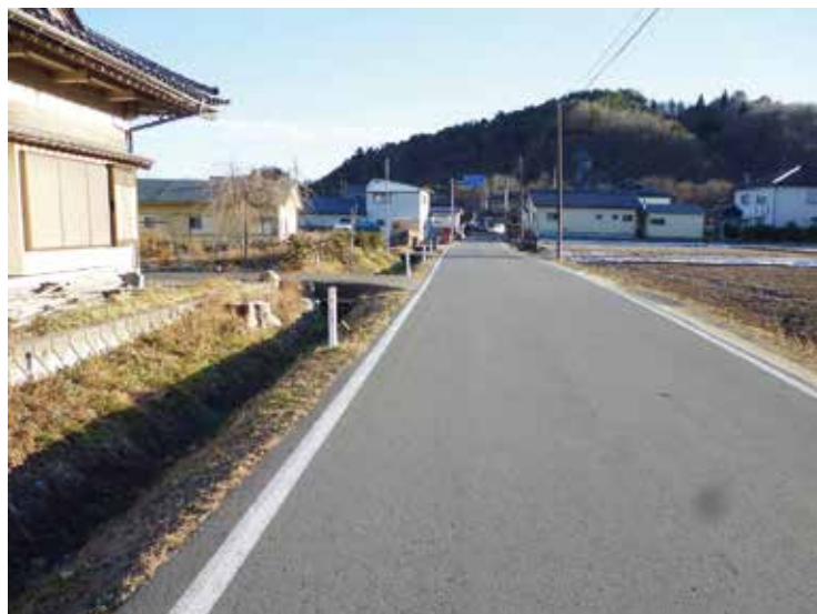
改良が望まれる町道八千代・白山線
