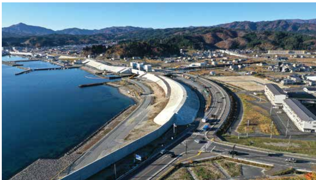
非常階段の設置が待たれる防潮堤
