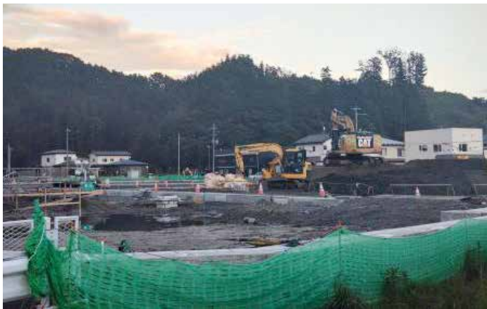
建設が進む 新・道の駅
