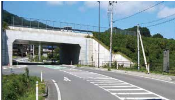
早期完成が期待される北インター
