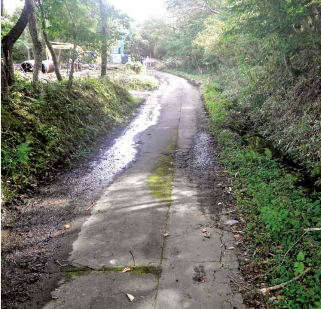
工事に着手した町道長林旧国道線と普通河川船越の沢川
