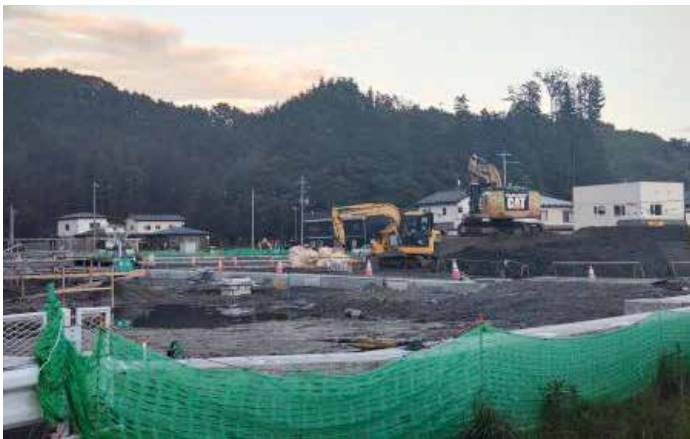
建設が進む 新・道の駅
