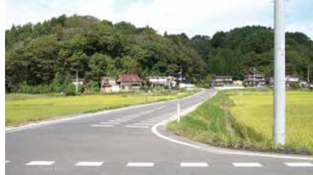
道幅が狭かった織笠礼堂地区の道路を拡幅しました
