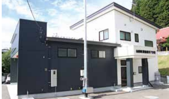
今年1月に完成した第7分団消防屯所
